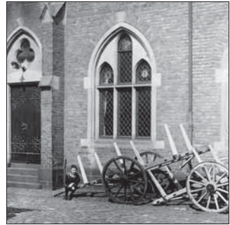
1899 Werner Schumacher wird am 1. Januar als Teilhaber in die Firma aufgenommen. 1910 Eingang zum Büro Landsbergstraße 16
