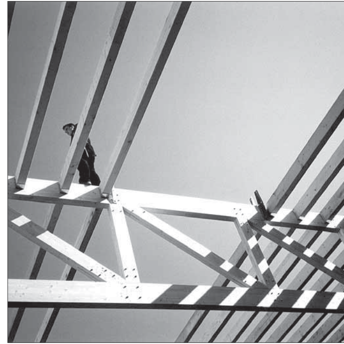
2002 Neubau der Holzhalle in Fachwerkbinder- konstruktion und 6 m hohen Kragarmregalen in der Achterstraße
